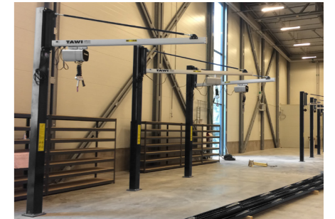
Les Potences TAWI peuvent être montées sur un mur ou un pilier, et des options portables sont disponibles.
