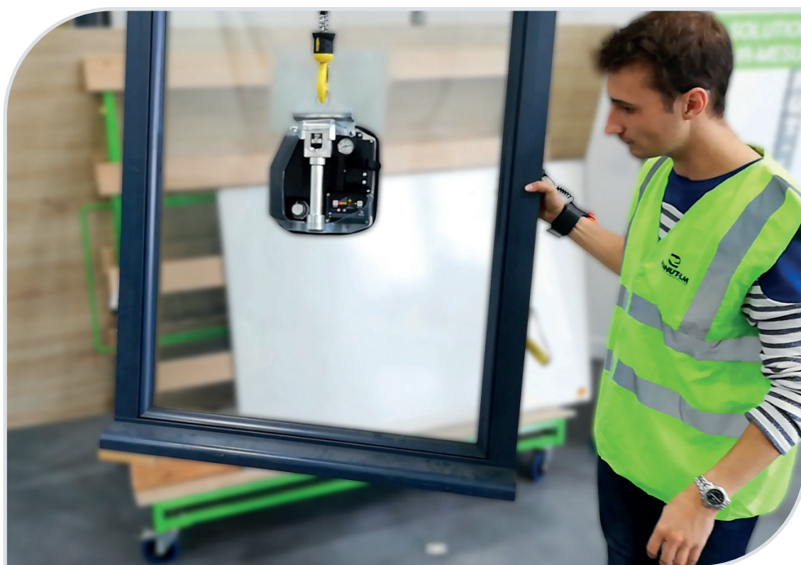
Manutention verticale de panneaux vitrés
